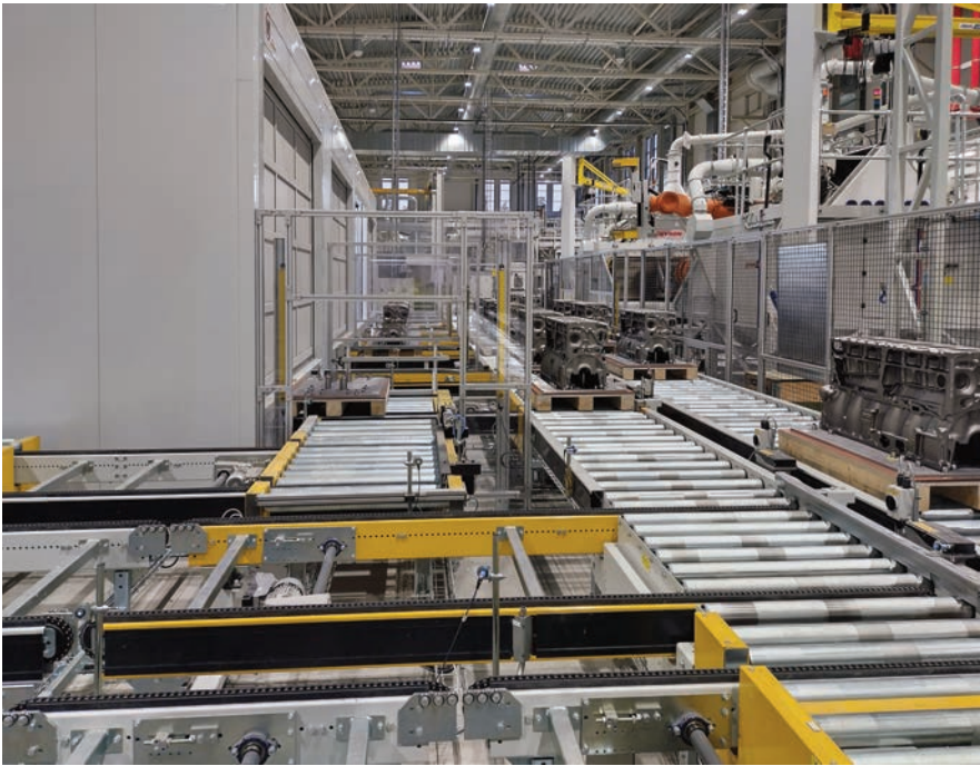
Flujo del producto a través del acabado automático en la nueva fundición
