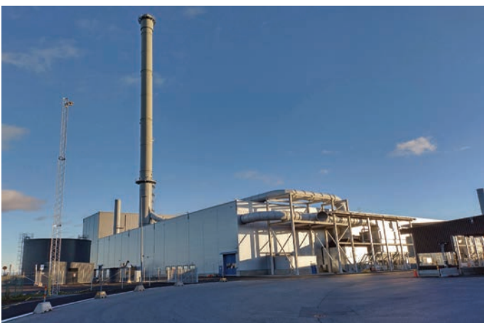
Nueva fundición de Scania en Södertälje, Suecia. Vista desde el noroeste de la zona de acabado y las tuberías de ventilación
