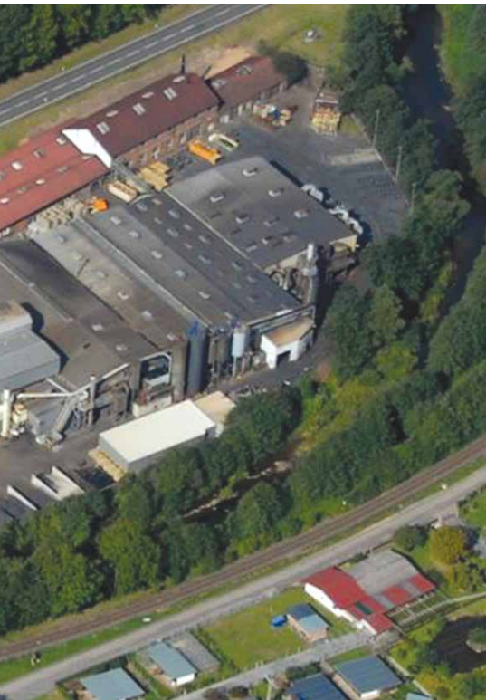
Luftansicht des Linde-Werks in Weilbach. Mit 157 Mitarbeitern gießt das Werk täglich ca. 180 Gegengewichte für Gabelstapler ab. Das Produktionsvolumen liegt bei rund 50 000 Tonnen jährlich.
